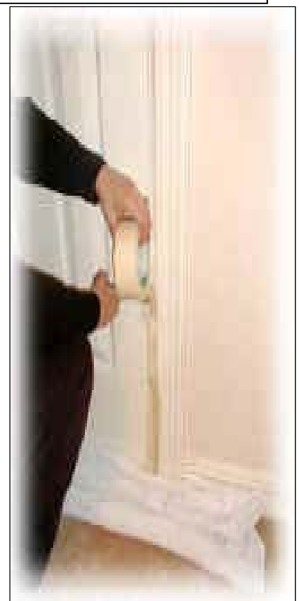
Sealing a Door Frame
